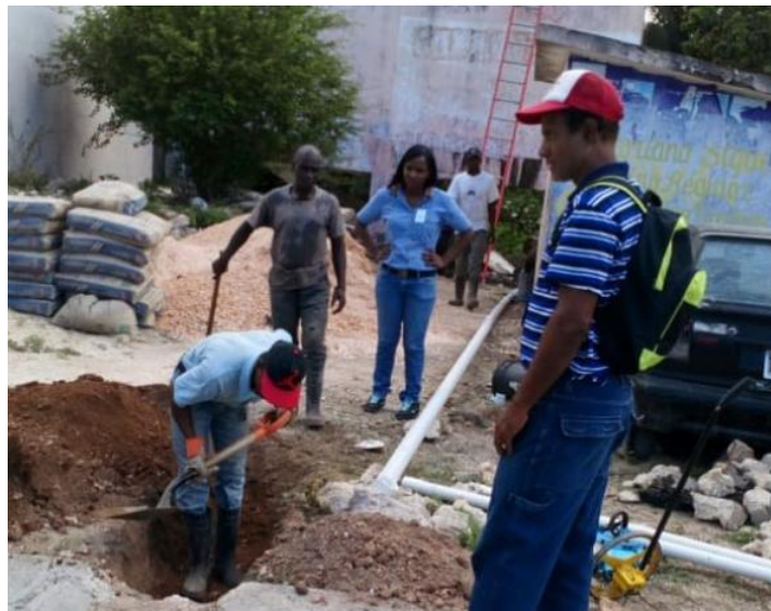
Rehabilitación de pozo (al fondo) construido en el año 1992, Con capacidad para 34 mil galones diarios.
