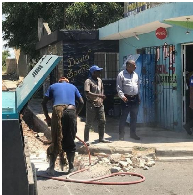
Trabajos de ampliación de redes en el Distrito del 10 de Cumayasa, constará de un 1 Km redes de tubería PVC, la reparación y ampliación tanque de almacenamiento y la instalación de un sistema de Bombeo de aguas subterráneas
