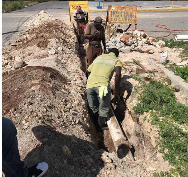
Ampliación de la red de distribución de agua potable Residencial Romana en el Distrito Municipal de Caleta
