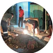
**Reparación de ruptura de tubería de 8 pulgadas en calle Hermanas Mirabal del sector de Villa Verde, municipio La Romana, ocasionada por un camión filtrante.**
